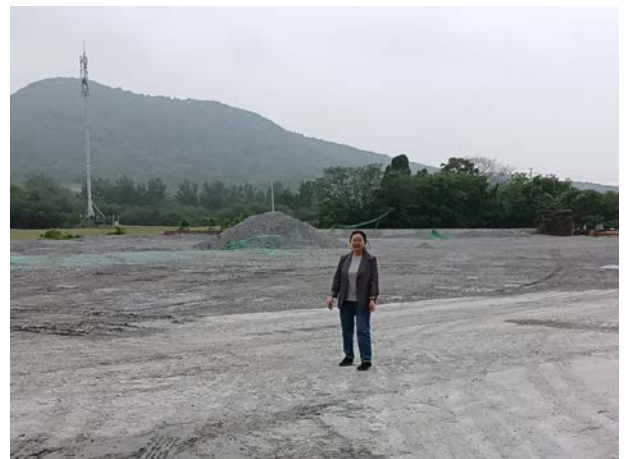
厂址现状及编制主持人现场勘查影像资料
